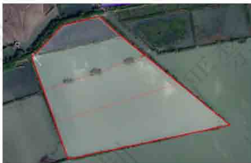
图 2-9 缓冲水域航拍图
