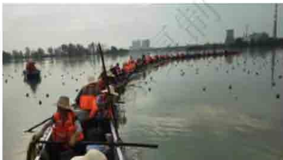
图 2-18 沉水植物施工实景图
